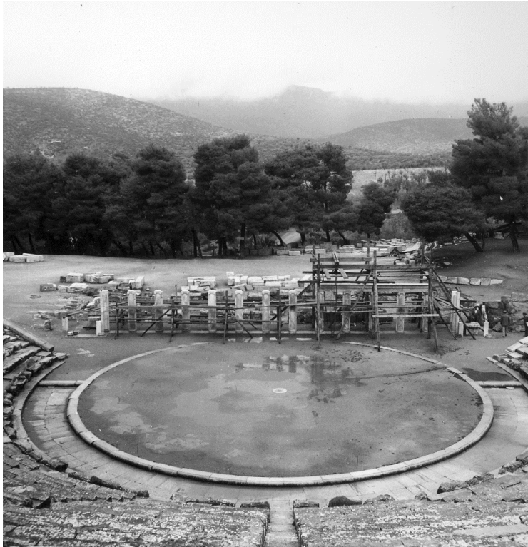
Εικόνα 6. Η δοκιμαστική αναστήλωση του προσκηνίου του θεάτρου του Ασκληπιείου της Επιδαύρου. Τοποθέτηση τμήματος του επιστυλίου. (Copyright © Η Εν Αθήναις Αρχαιολογική Εταιρεία, Φωτογραφικό αρχείο, ηλεκτρονική μορφή).
